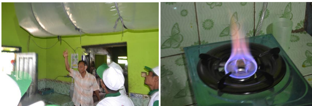
Gambar 3. Produksi biogas yang terbentuk mengalir ke penampung gas plastik dan nyala kompor
