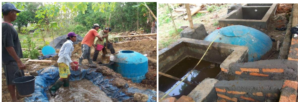
Gambar 2. Pemasangan biodigester dan pengisian campuran kotoran sapi dan air (1:1)
